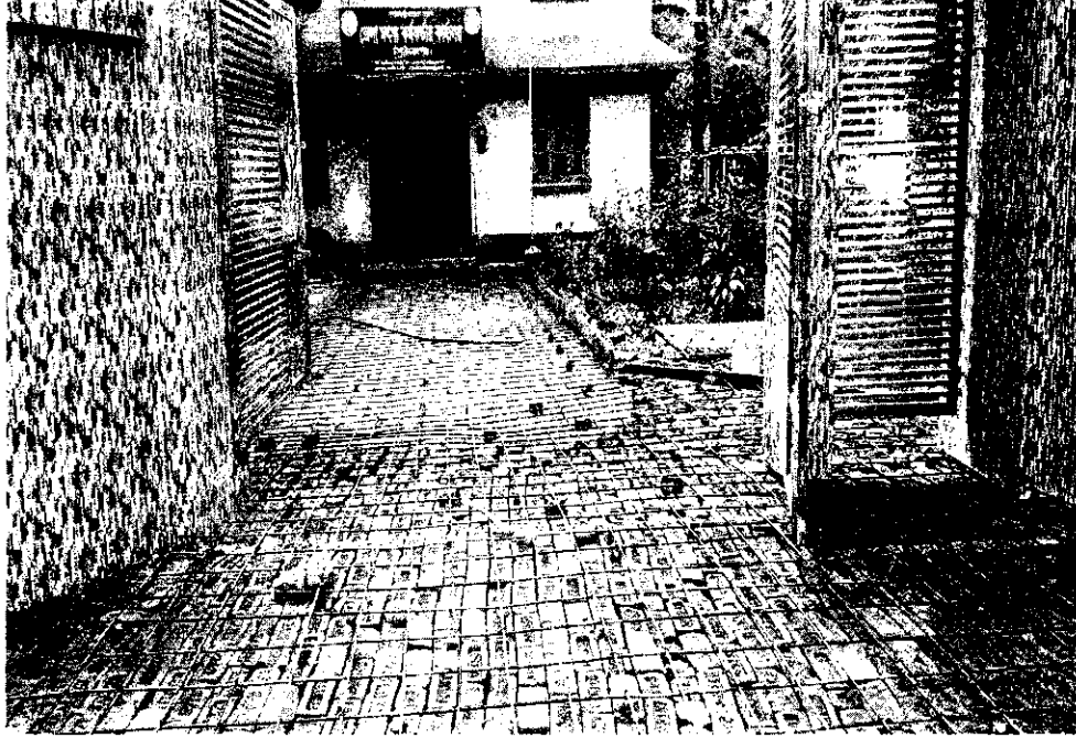
রাস্তা মেরামত কার্যক্রম চলাকালীন ছবি
