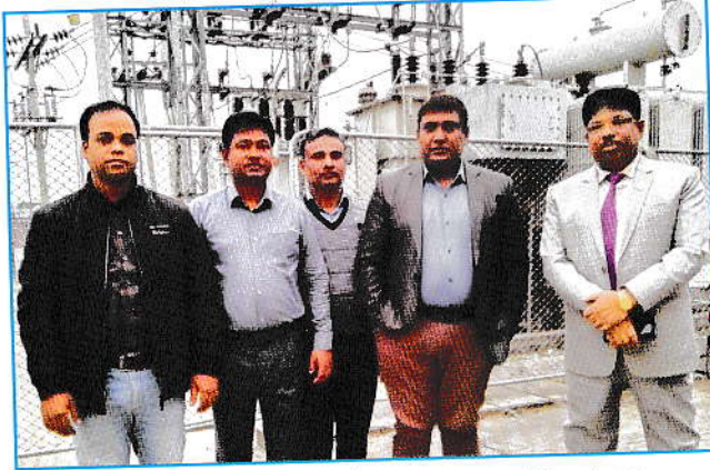
বেড়া-১ সাবস্টেশন পরিদর্শন করছেন রাজশাহী জোনের তত্ত্বাবধায়ক প্রকৌশলী মহোদয় সাথে সমিতির জি এম, ডিজিএম ও সহকারী প্রকৌশলী।
